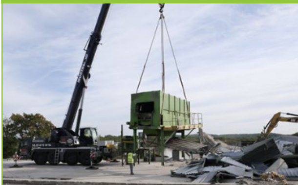
Déconstruction écoresponsable de l'ancien centre de tri de Catus
